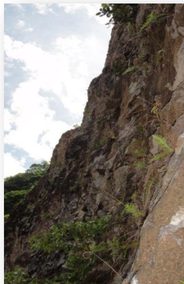
Fotografía 41 y 42. Mostrando cuerpo del talud donde se observan suelos y rocas sueltas que deberán ser evacuadas prioritariamente.
