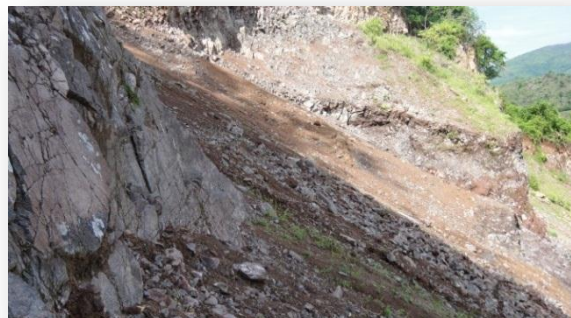
Fotografía 43 y 44. Mostrando presencia de rocas muy intemperizadas presentando juntas y grietas, en el sector donde se proyecta la colocación de la malla de doble torsión para controlar desprendimientos.
