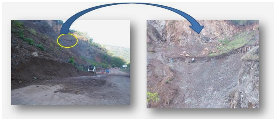
Fotografías 3 y 4. Vista general del último derrumbe de mayo y explotación del talud como banco de préstamo.
