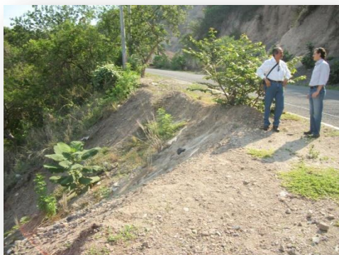
Erosión de talud de margen derecha y vista general del talud objeto de estudio
