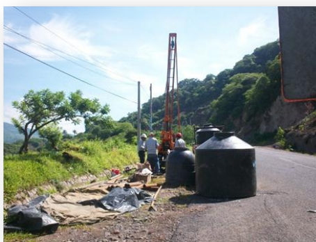
Fotografías 16 y 17. Vista ejecución sondeo rotativo S-3R
