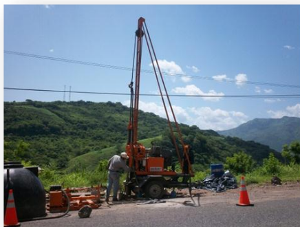
Fotografías 18 y 19. Vista ejecución sondeo rotativo S-4R
