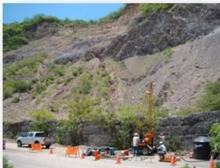
Fotografías 12 y 13. Vista ejecución sondeo rotativo S-1R
