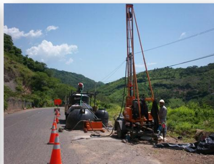
Fotografías 18 y 19. Vista ejecución sondeo rotativo S-4R
