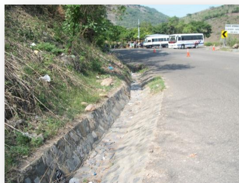
Canaleta Triangular 1.3 m de ancho superior, 0.5 m de base con una altura de 0.50m de profundidad con una capacidad de 981 lts/seg (Tabla 2)
