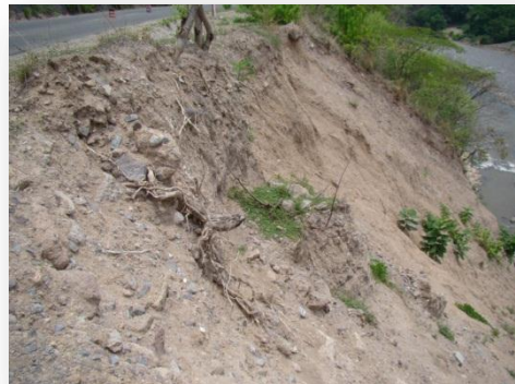
Fotografías 6 y 7. Escarpados en la vía y deslizamientos en el talud colindante con el Río Paz.
