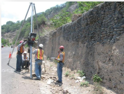
Fotografías 8 y 9. Ejecución de sondeos del tipo Penetración Estándar (SPT) a ambos lado de la vía.
