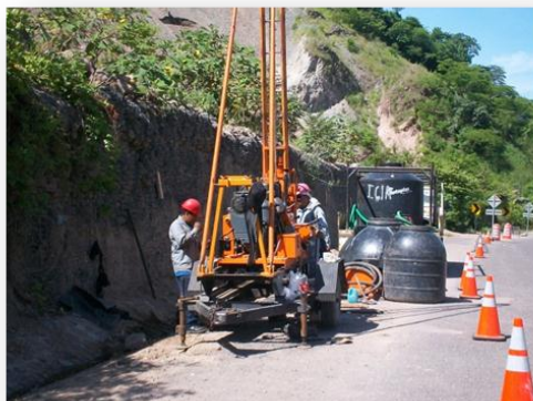
Fotografías 20 y 21. Vista ejecución sondeo rotativo S-5R
