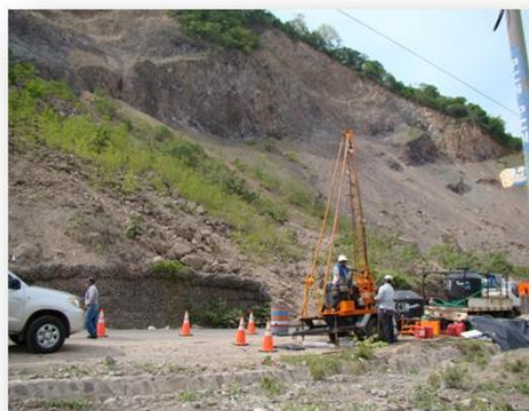
Fotografías 14 y 15. Vista ejecución sondeo rotativo S-2R
