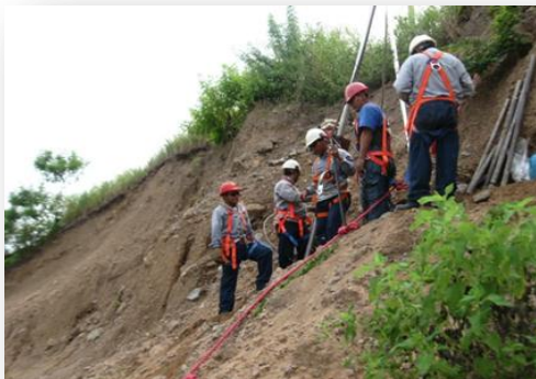
Fotografías 10 y 11. Ejecución de sondeos del tipo Penetración Estándar (SPT) en talud lateral derecho.
