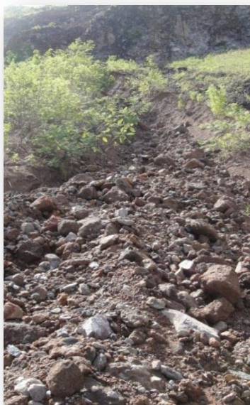
Fotografía 41 y 42. Mostrando cuerpo del talud donde se observan suelos y rocas sueltas que deberán ser evacuadas prioritariamente.
