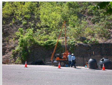
Fotografías 20 y 21. Vista ejecución sondeo rotativo S-5R
