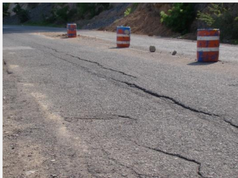
Fotografías 6 y 7. Escarpados en la vía y deslizamientos en el talud colindante con el Río Paz.
