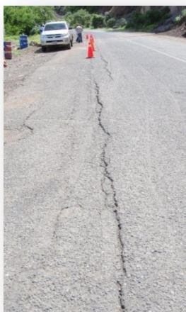
Fotografías 39 y 40. Vista de la grieta del escarpado existente en el lateral derecho.
