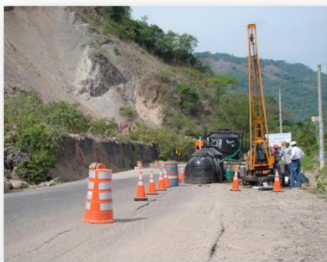
Fotografías 14 y 15. Vista ejecución sondeo rotativo S-2R
