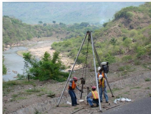
Fotografías 8 y 9. Ejecución de sondeos del tipo Penetración Estándar (SPT) a ambos lado de la vía.
